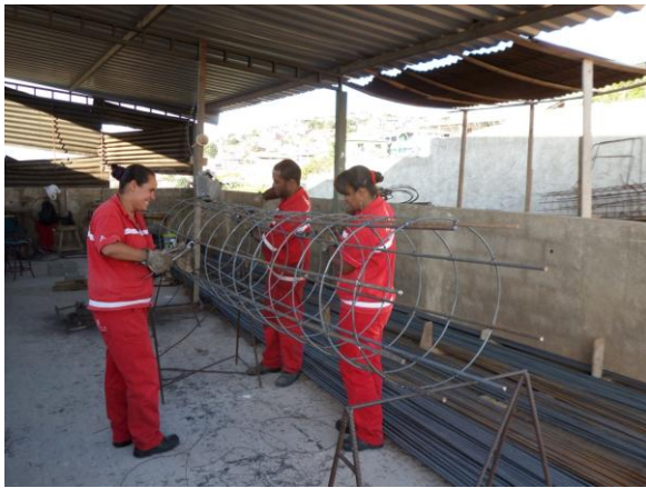
Montagem da estrutura do tubulão com orientação do Pear
