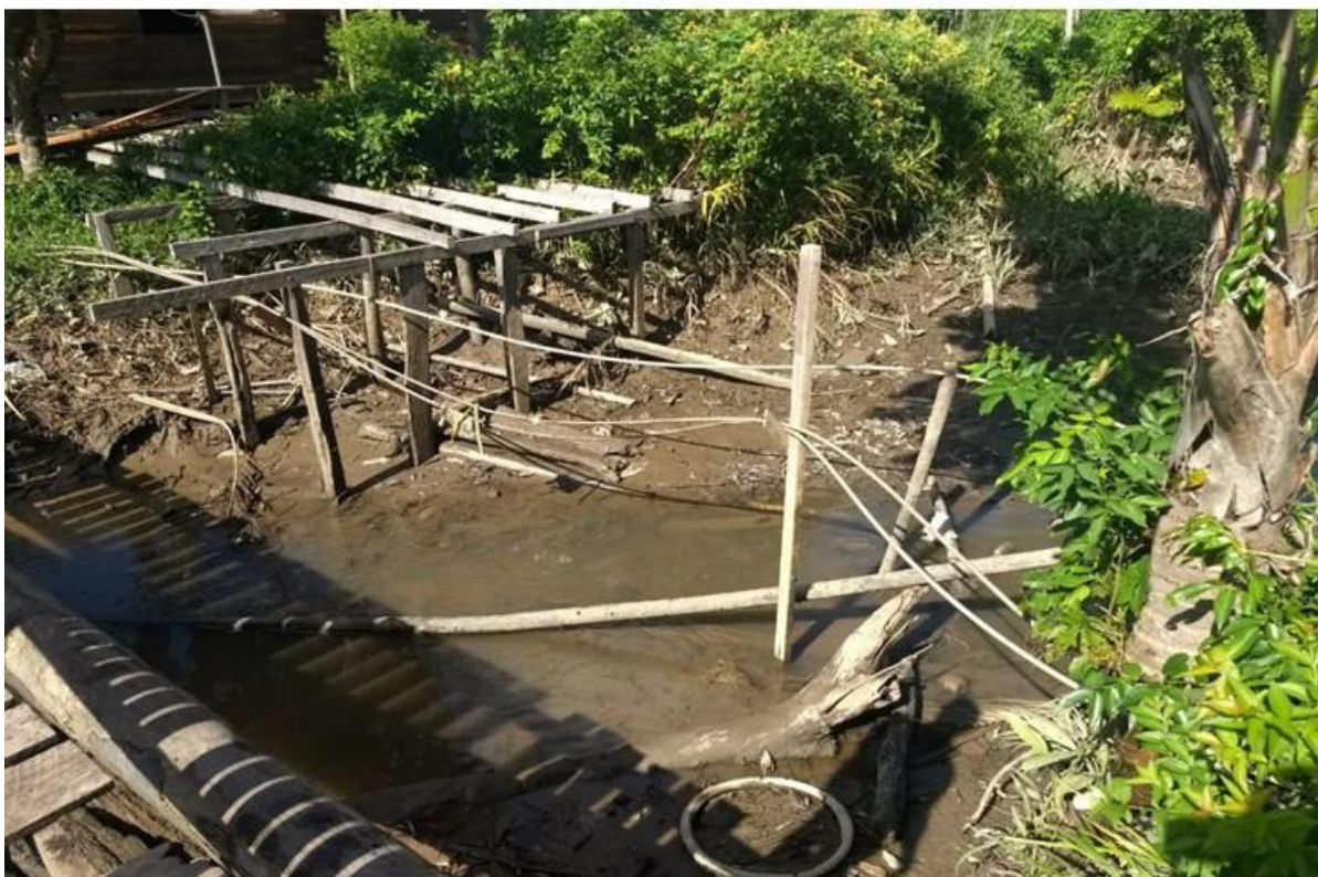
Figura 3. Falta de saneamento básico em Limoeiro do Ajuru
