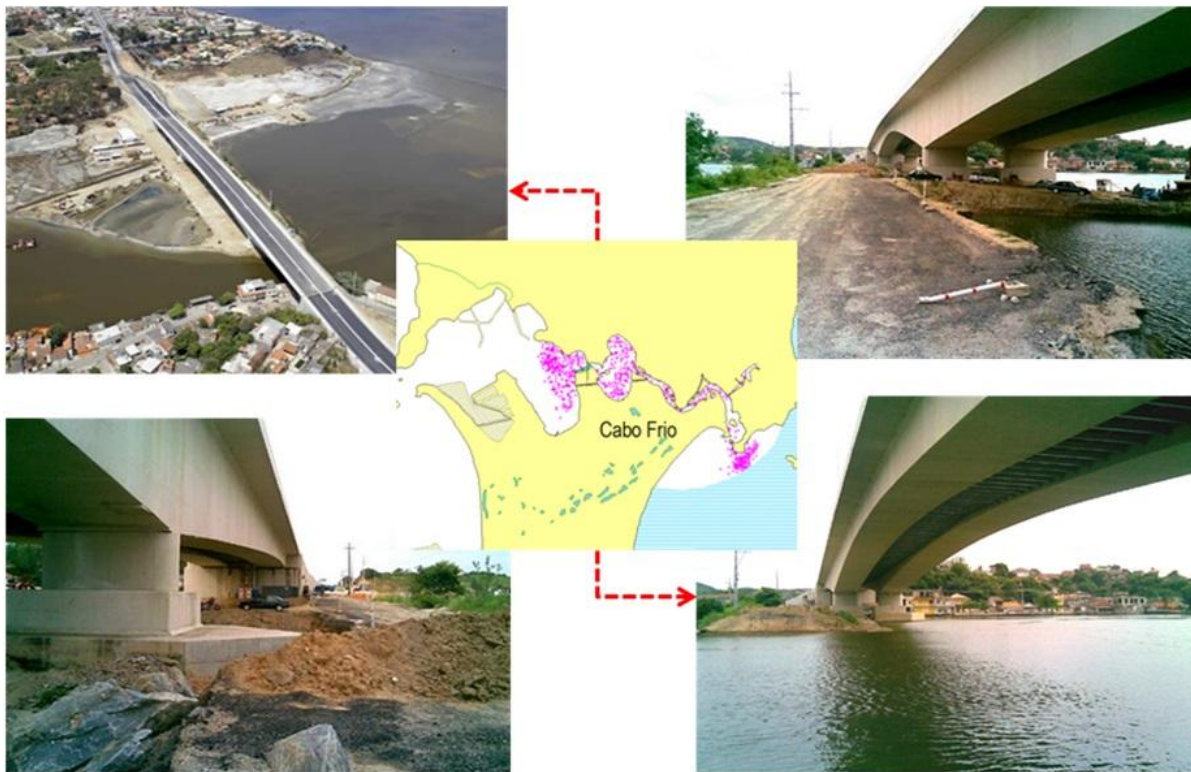
Estrutura da ponte sobre o canal de Itajurú, Cabo Frio.
