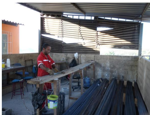
Corte e dobra do aço para a montagem da estrutura
