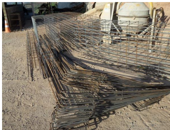
Aços montados para carregamento e envio a obra a ser executada pelo morador
